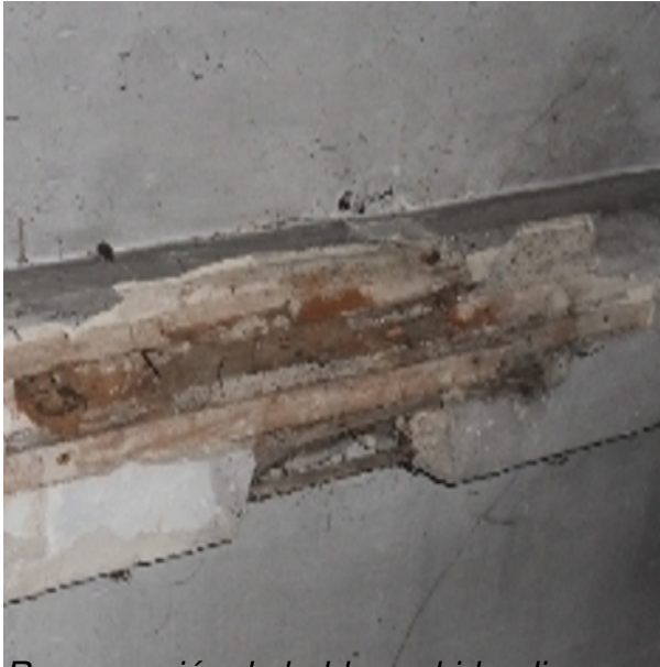
Recuperación de baldosas hidráulicas y recolocación de las mismas
